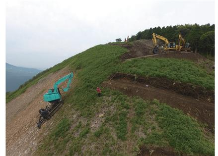
写真5:法面掘削作業完全無人化工法(熊本県)
