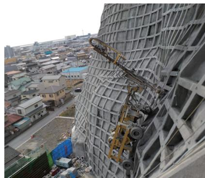
写真1: 削孔作業を行うARM07型(宮城県)
