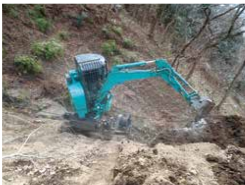
2017年に発生した台風では土砂崩れにより高速道路が通行不能になりました。この復旧工事でRCMは掘削や伐根などの作業を行いました。
