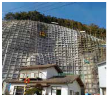
2017年に発生した台風では土砂崩れにより高速道路が通行不能になりました。この復旧工事でRCMは掘削や伐根などの作業を行いました。
